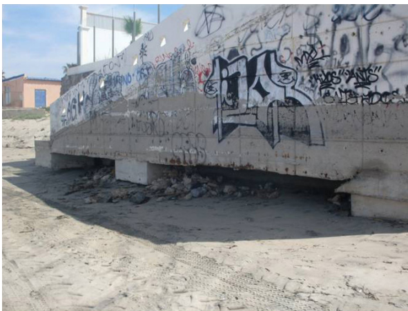
Figura 5. Muro construido en la región central de las costas de la Bahía de Todos Santos que presenta erosión por oleaje en su base.
