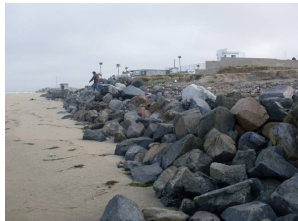
Figura 3. Enrocamientos construidos en la región Sur de las costas de la Bahía de Todos Santos.
