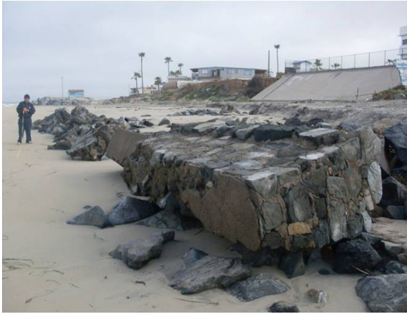
Figura 4. Muro colapsado construido en la región Sur de las costas de la Bahía de Todos Santos.
